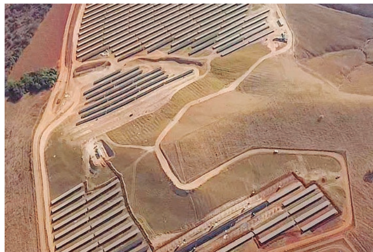
O projeto da ForGreen prevê a instalação de 55 usinas solares até o primeiro trimestre do próximo ano FOTO: DIVULGAÇÃO / FORGREEN
