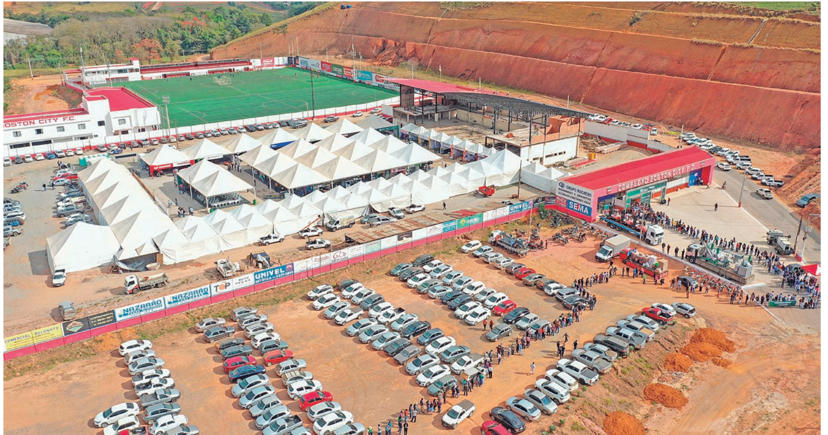
Complexo está sendo construído em um espaço de cerca de 150 mil m 2 , que antes abrigava o parque de exposições da cidade FOTO: DIVULGAÇÃO / BOSTON CITY
