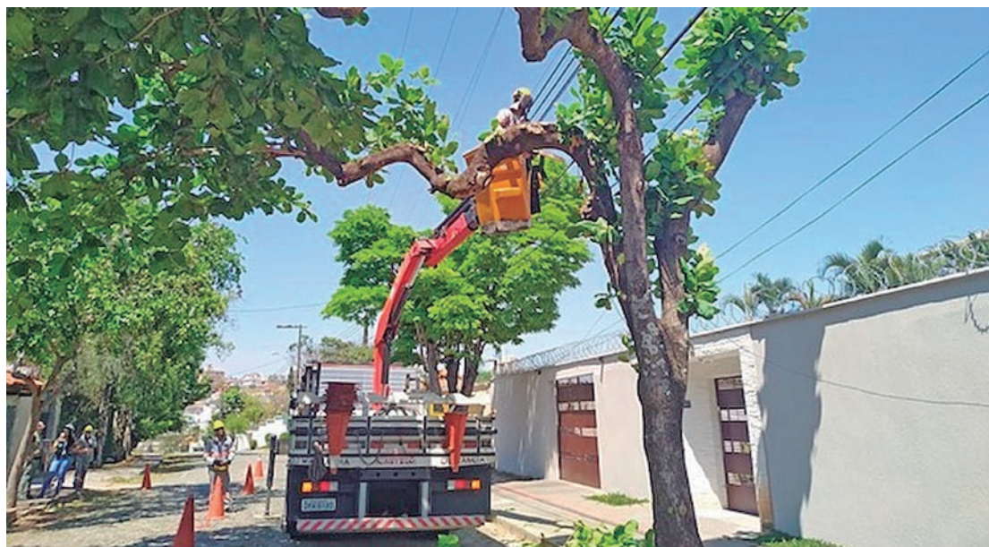
De acordo com a Aneel, houve 1.761 interrupções decorrentes de "falha de material ou equipamento" em Fronteira entre janeiro de 2022 e setembro de 2023. FOTO: DIVULGAÇÃO / CEMIG
