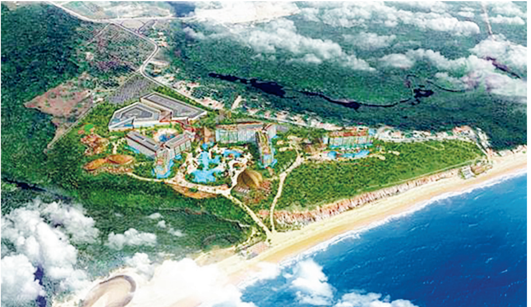
O Tauá Resort João Pessoa será construído em uma área de 300 mil metros quadrados, à beira mar da Praia de Jacarapé
