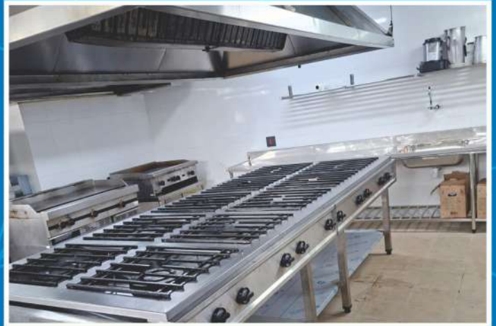
Reforma da cozinha do Restaurante Panorâmico
